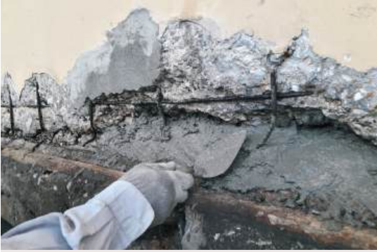
Tamir-Onarım ve Güçlendirme
